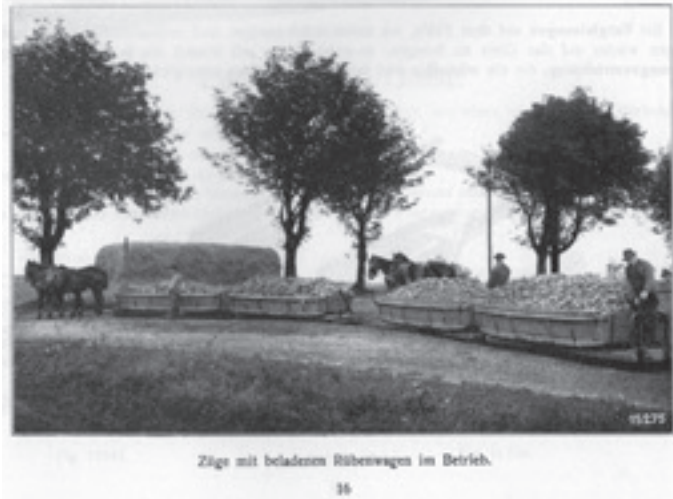
Bildtext: Rübentransport auf einer Feldbahn. Quelle: Katalog von Orenstein & Koppel um 1912
