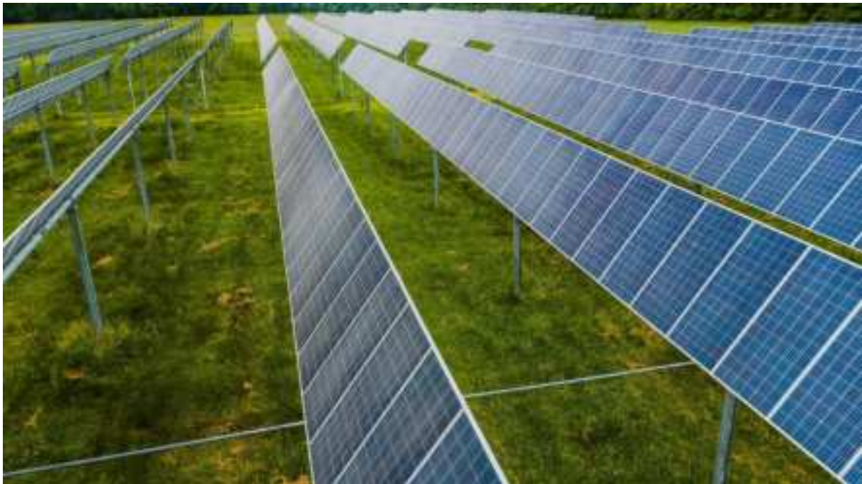
Abbildung 41 Beispielfoto für eine Agri-PV-taugliche Anlagenkonzeption mit erhöhter Aufständigung und großen Reihenabständen (Bildquelle: pexels.com).
