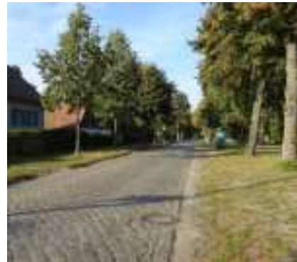
Schacht des bestehenden Mischwasserkanals in der Hobrechtsfelder Dorfstraße (Aufnahme BCE)
