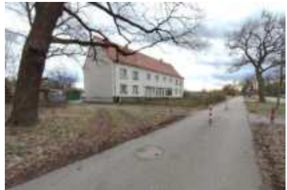
Abbildung 30 Blick auf die Poller und die durch ein Kfz hinterlassenen Spuren ihrer Umfahrung. Bildquelle: mellon
