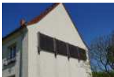
Beispiel erneuerbare Wärmeerzeugung (Solarthermie) in Hobrechtsfelde. Quelle: mellon
