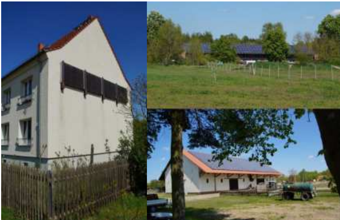
Abbildung 39 Solarthermie (links) und PV-Anlagen (rechts) in Hobrechtsfelde
