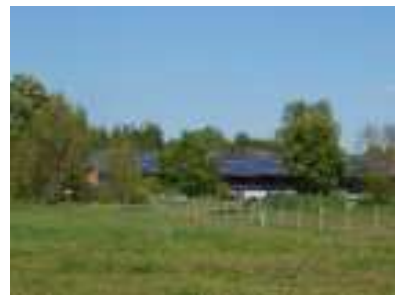
PV-Anlage in Hobrechtsfelde. Quelle: mellon
