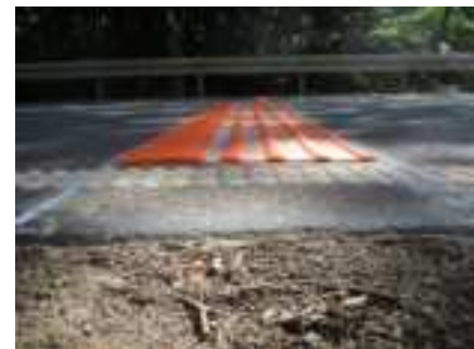
Rüttelstreifen im Profil. Quelle: NLStBV
