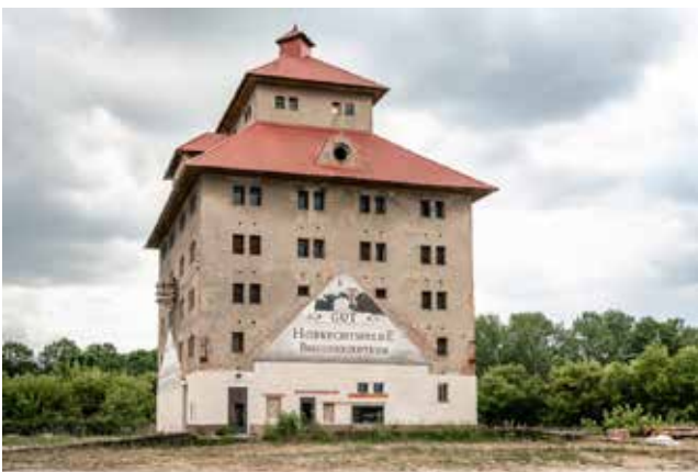
25 | Besucherzentrum Hobrechtsfelde im alten Kornspeicher
