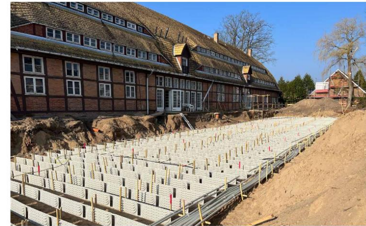
Verlegt 3: 180 Stränge in zwei Ebenen für eine Wärmepumpenleistung von 150 KW.
