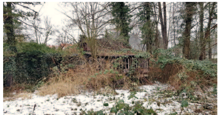
Eine von insgesamt 5 verwucherten Hütten, welche nun abgerissen wurden. (Foto: Fotschki)
