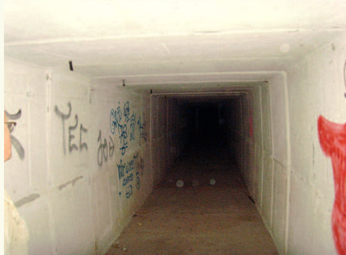
Schießtunnel von innen (100 m lang)
