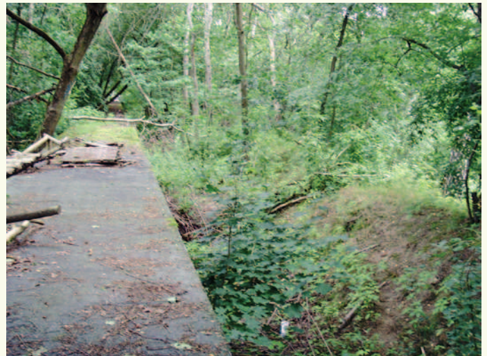
Dach des Schießtunnels (Betonröhre) mit Erdwall, der der Tarnung dienen sollte
