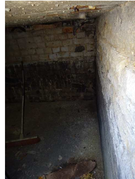
Abb. 3. Keller des Gebäudes.
